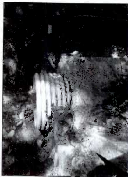
Foto No. 5 Punto de vertimiento de tubería de aguas residuales.
