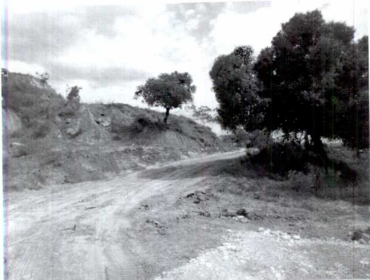
Foto No. 3 Al fondo estado de la cobertura natural y área intervenida
