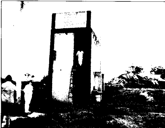
Foto 9. Aspecto externo de la infraestructura existente para el tratamiento de las aguas residuales industriales, la cual está construida en tres niveles a saber: en el nivel más bajo, enterrado se encuentra el denominado tanque de llegada, que en la diligencia no se pudo inspeccionar, por no facilitarse el acceso; no obstante, desde la parte superior de la puerta se tomó el registro fotográfico que se muestra en seguida. A nivel del terreno se encuentra un cuarto de bombeo y en el tercer nivel, al cual se accede por una escalera en madera, se encuentran las referidas unidades correspondientes al tanque de fibra de vidrio para filtrado, los tanques para inyección de oxígeno y el filtro de carbón activado; en un espacio de no más de 15m 2 , totalmente encerrado.
