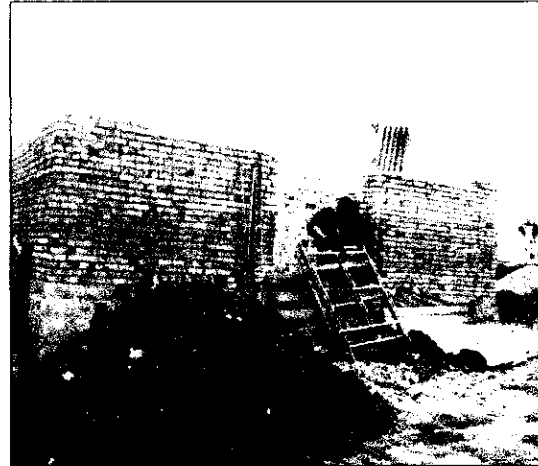
Foto 29. Quemador para huesos y cascos en construcción en cercanías al río Bogotá.
